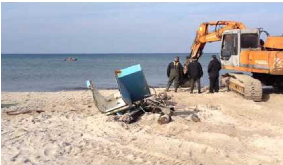
Zdjęcie nr 3. Usuwanie wraku łodzi pokładowej UST-83
