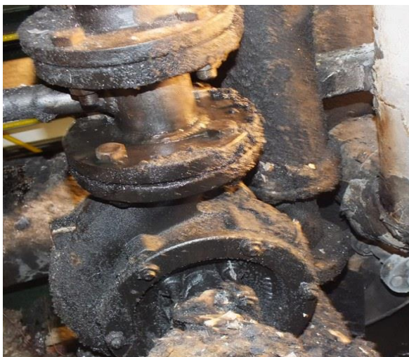
Zdjęcie nr 5. Łącznik kołnierzowy DN65 pompy cyrkulacyjnej nr 1 oleju grzewczego
