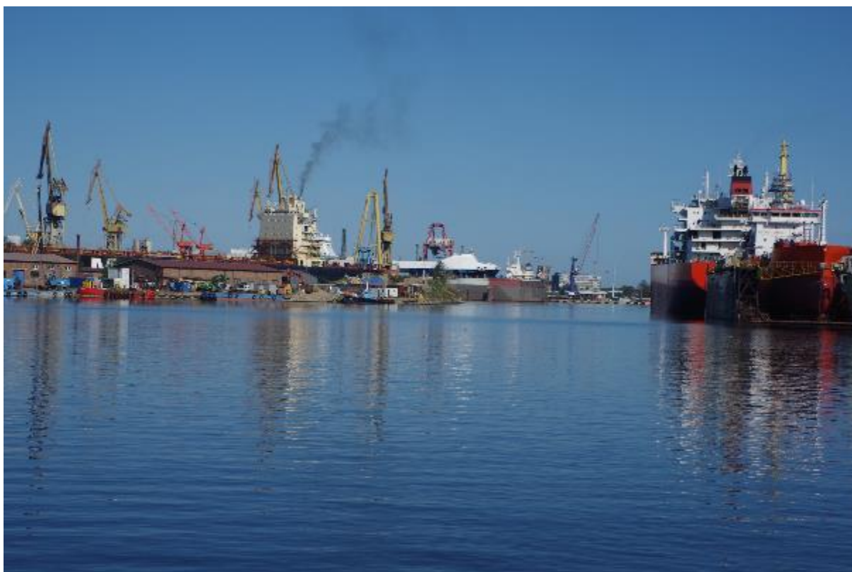
Zdjęcie 4 – Widok z nabrzeża na kanał pomiędzy nab. Ostrawica 1, a nietrwale nabrzeże Hydrobudowy
