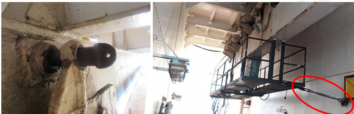
Aranżacja zabezpieczenia na statku siostrzanym – sworzeń zabezpieczający (oryginalna konstrukcja) oraz zmodernizowane zabezpieczenia (z przyspawanym uchem – czerwony owal)
