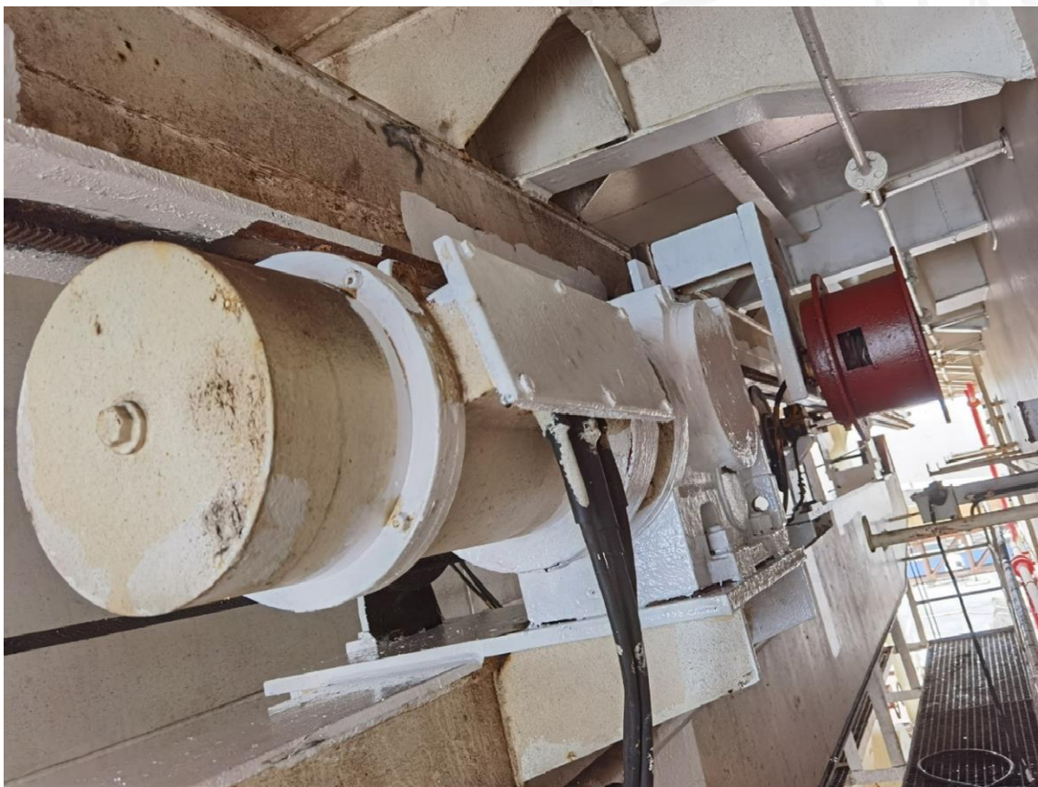
Urządzenia dźwigu oraz dwuteownik – widok z platformy serwisowej (od dziobu, przed wypadkiem)
