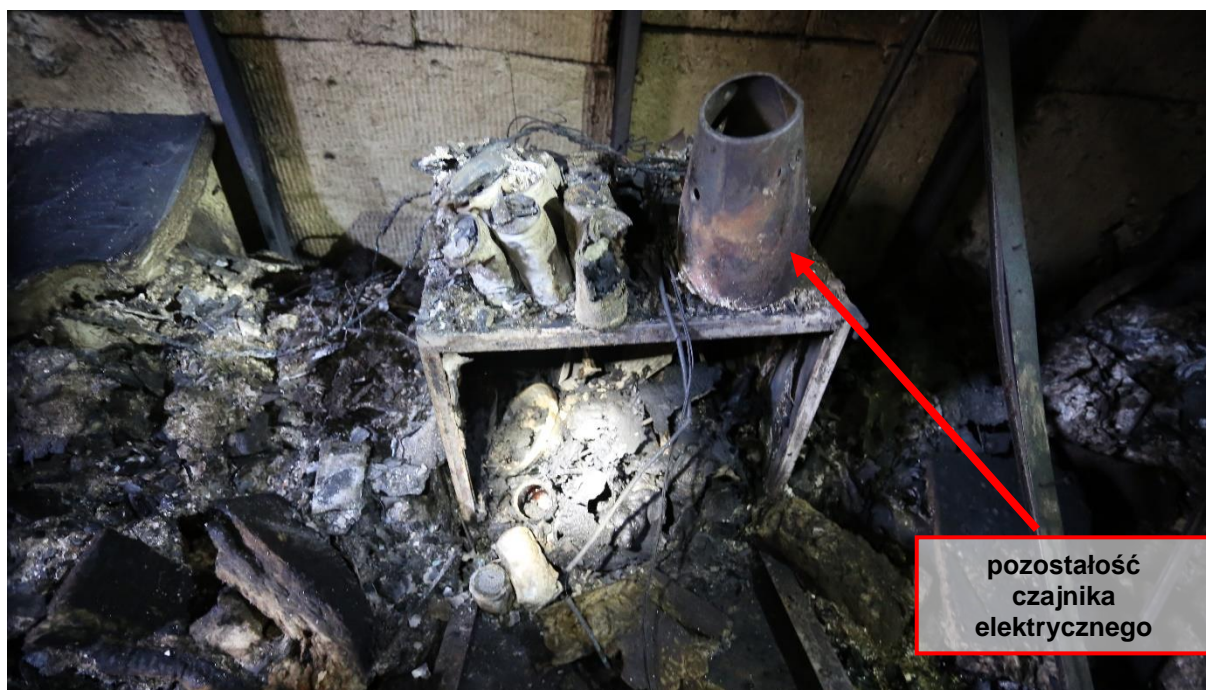
Fot. 9. Wnętrze kabiny nr 34
