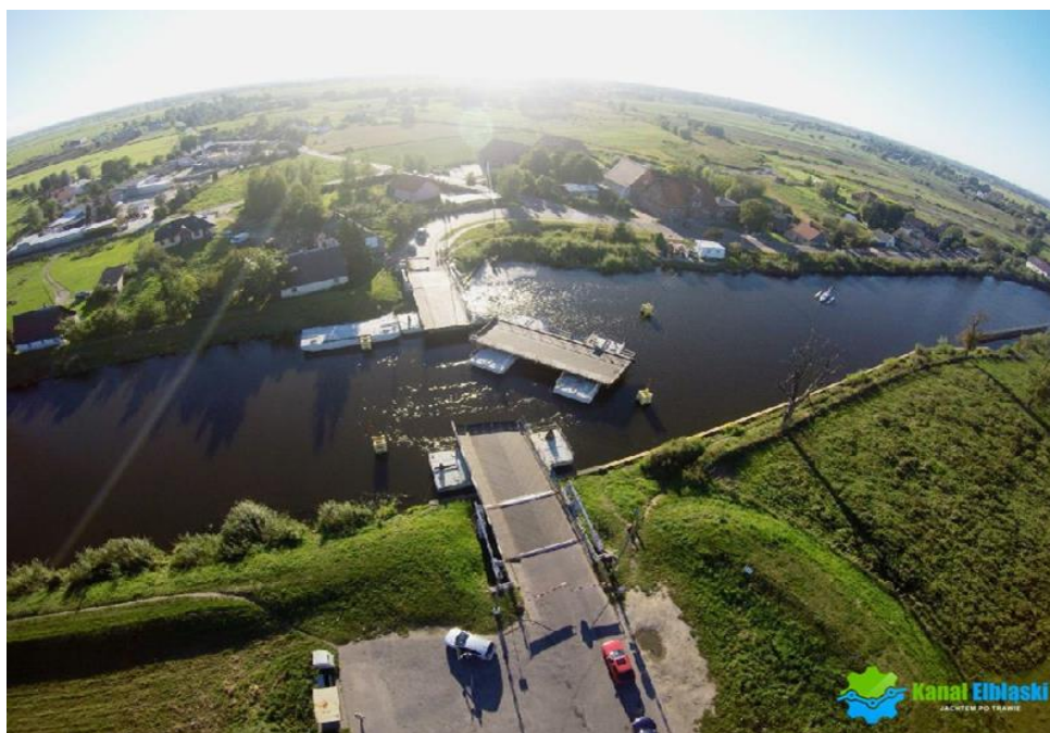
Zdjęcie 1 - Most w Nowakowie w trakcie otwierania. Widoczne 4 żółte stawy odbojowe między którymi przepływał zestaw pchany ( źródło: https://kanal-elblaski.pl )
