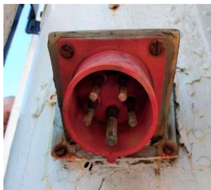
Zdjęcie nr 9 Gniazdo zasilania z lądu
