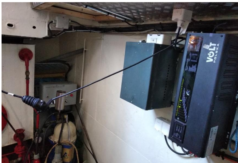
Rysunek nr 10 Podłączenie przetwornicy do zasilania z lądu
