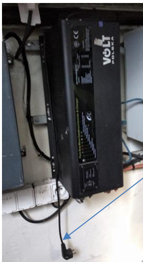
Rysunek nr 8 Przetwornica Power Sinus 3000 24V
