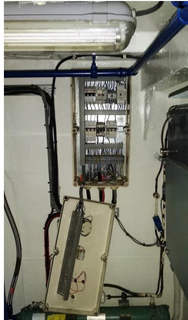
Zdjęcie nr 3 Rozdzielnica chłodni
