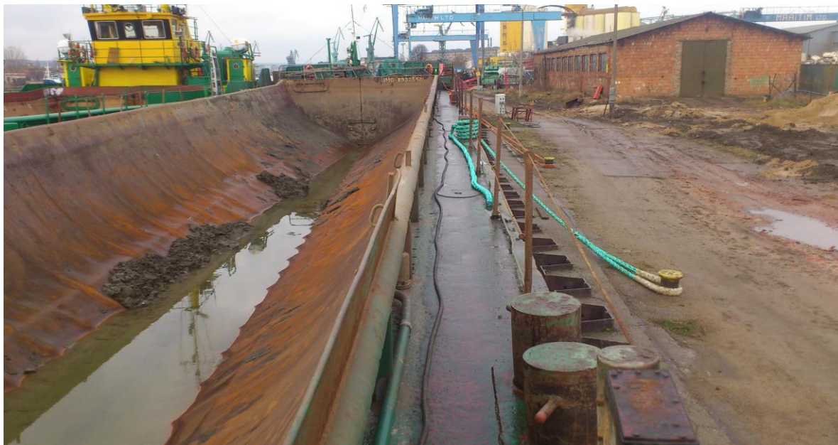
Zdjęcie nr 4. Pokład szalandy z postawionymi barierami ochronnymi (relingami po remoncie)
